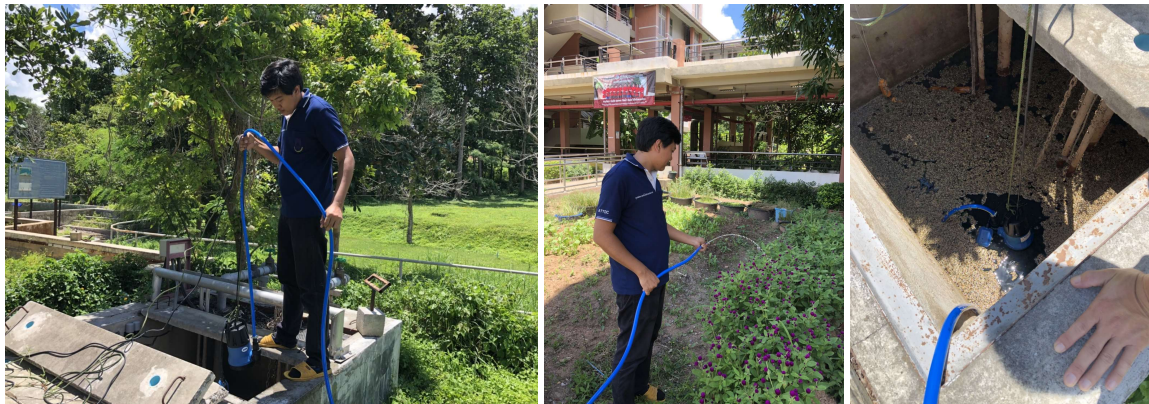
ภาพ 15 การรั่วน้ำเสียจากบ่อพักมารดน้ำต้นไม้
