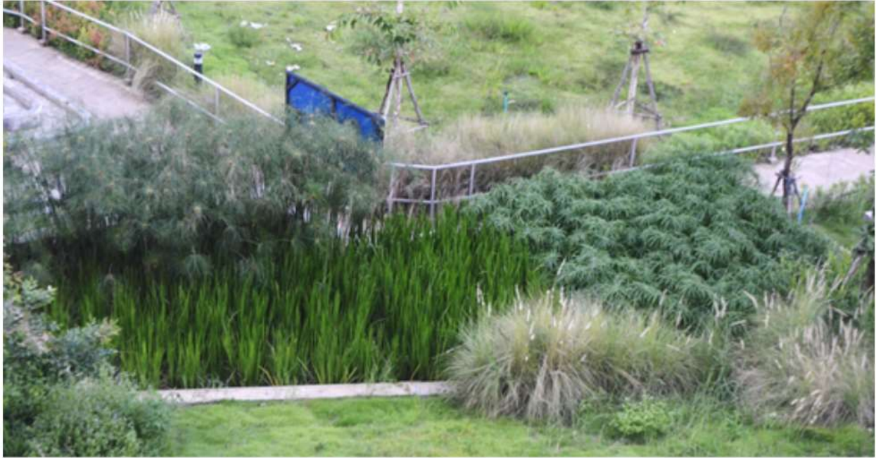
ภาพ 9 ระบบแบบการไหลใต้ผิวชั้นกรองในแนวราบ (HF)
