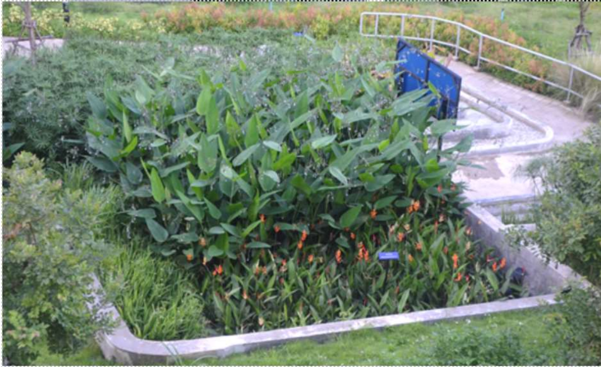
ภาพ 11 ระบบแบบน้ำไหลใต้ผิวชั้นกรองในแนวตั้ง (VF)
