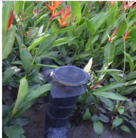
ภาพ 8 ท่อน้ำออกระบบ HF
